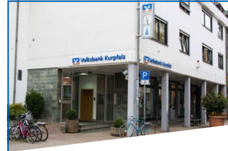
Filiale Ziegelhausen Kleingemünder Str. 33, 69118 Heidelberg
